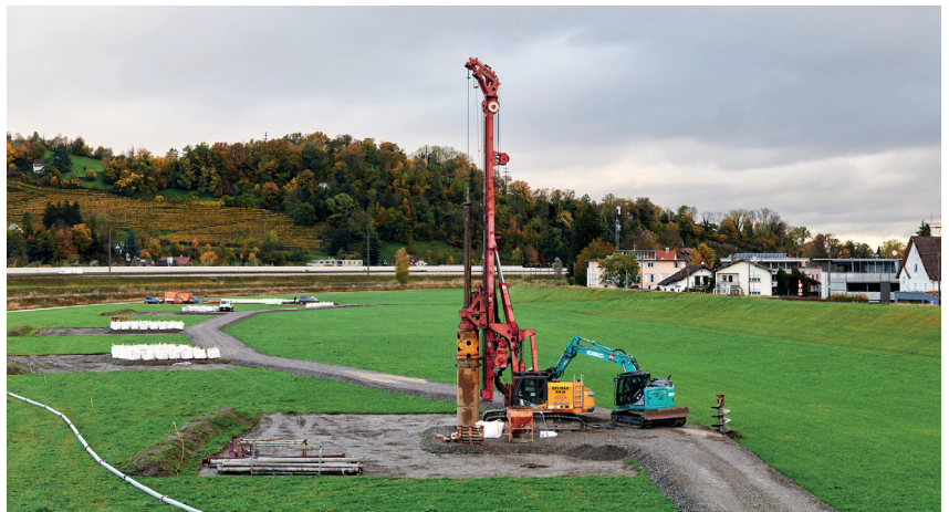
Bau der neuen Trinkwasserbrunnen in Lustenau.
