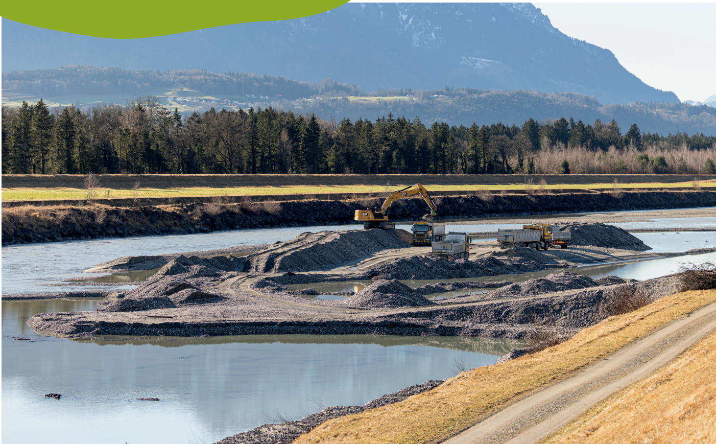
Bagger und Lastwagen «im» Fluss.
