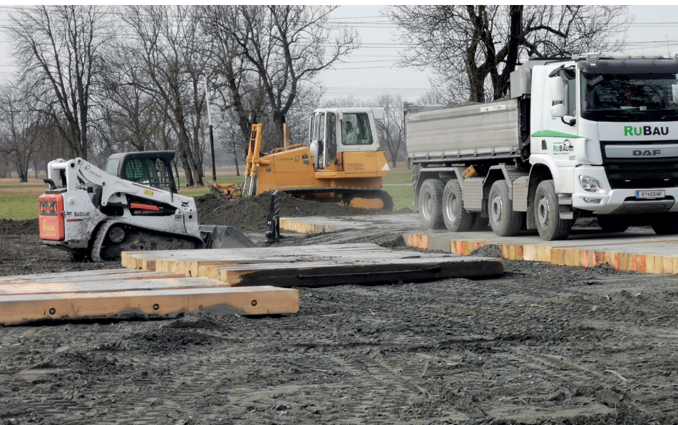
Versuche zu Bodenverbesserungen.
