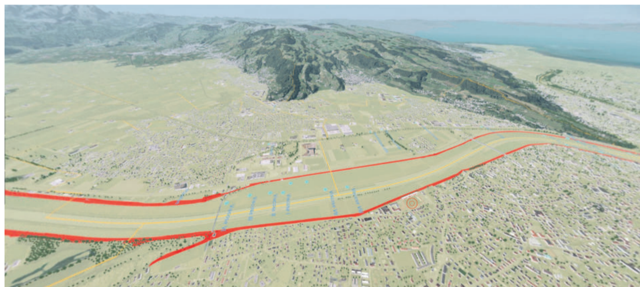
Das Gefährdungsszenario zeigt, wie verheerend sich an dieser Stelle ein Überschwemmung auswirken könnte. Quelle: www.rhesi.org
