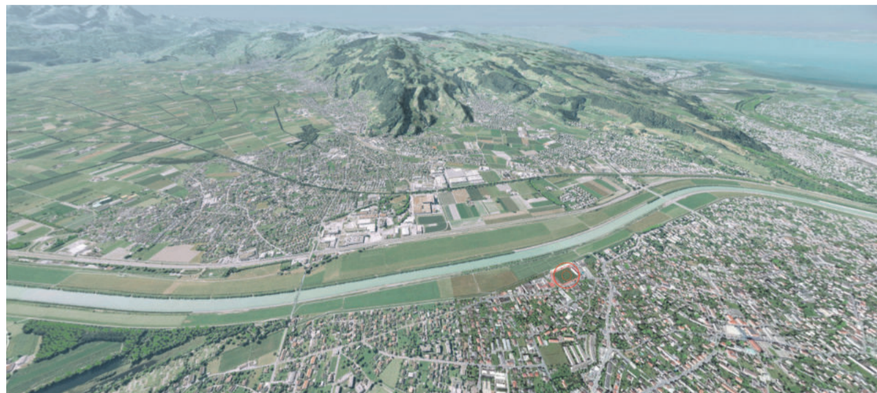
Zwischen Widnau / Au und Lustenau ist die Überbauung am Rhein besonders dicht. Quelle: www.rhesi.org
