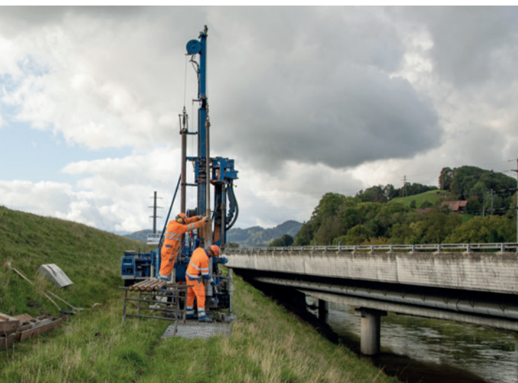
Kernbohrungen am Hochwasserdamm bei St. Margrethen
