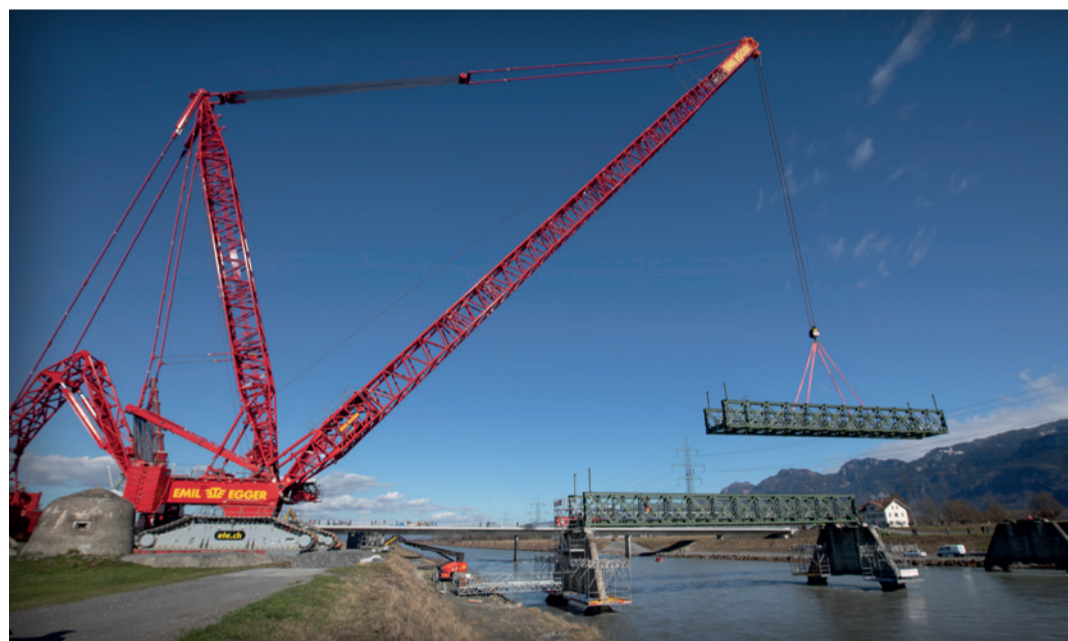
1000 Tonnen-Kran hob letzte Brückenteile aus dem Rhein (März 2020).
