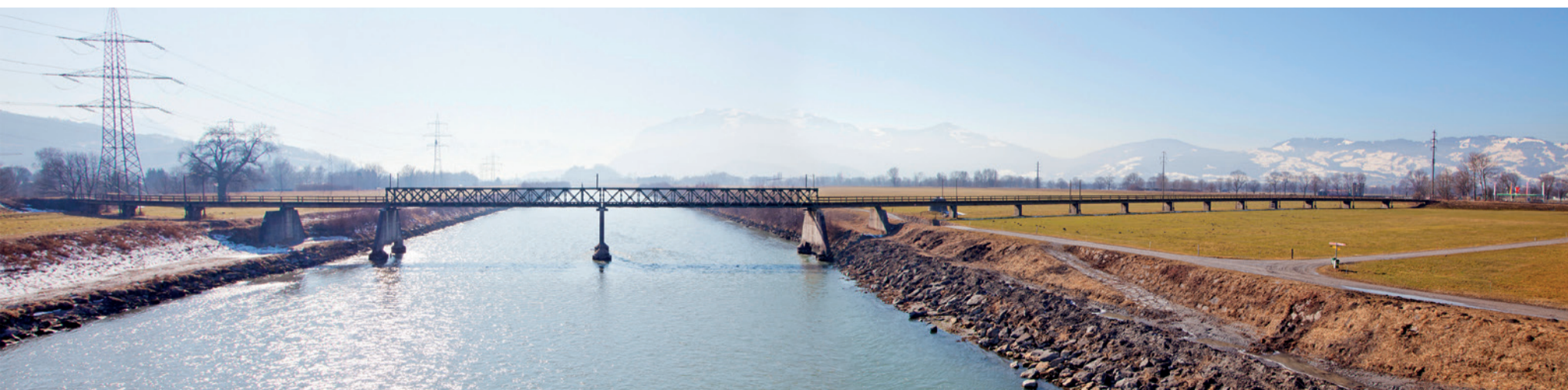
Dienstbahnbrücke im Originalzustand 2012
