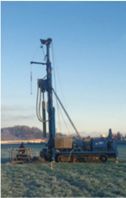
Bohrungen und Sondierungen für das neue Grundwassermodell.
