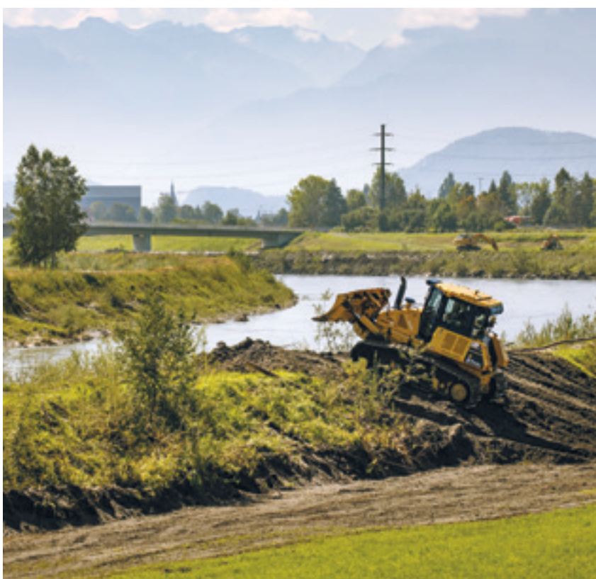
Bauarbeiten am Rhein.
