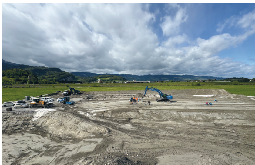
Baustelle Versuchsdamm bei Meiningen.
