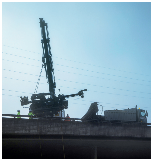
Die Bohrmaschine wird über das Brückengeländer gehievt.
